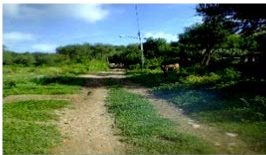
Imagen 3. Se observa servicio de energía eléctrica y alumbrado público sobre la calle 20 de noviembre. Fuente: Propia (2018).
