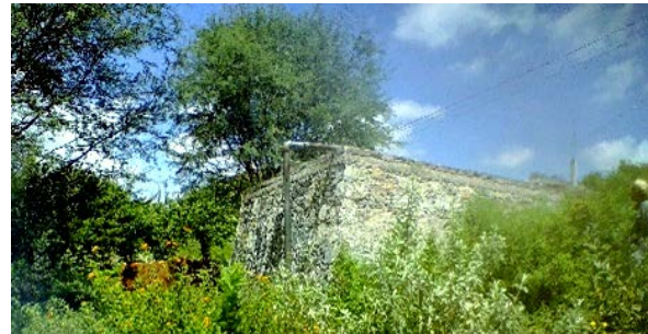
Imagen 2. Tanque superficial de mampostería de la localidad. Fuente: Propia (2018).
