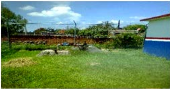
Imagen 1. Pozo de agua que proporciona servicio a la localidad. Fuente: Propia (2018).
