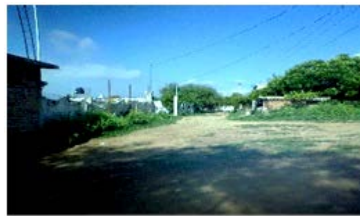
Imagen 4. Servicio de energía eléctrica sobre la calle 5 de mayo. Fuente: Propia (2018).
