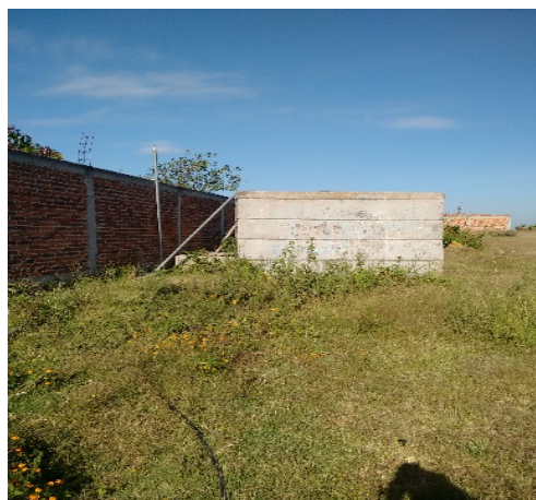
Imagen 2. Tanque superficial en calle Miguel Hidalgo de la localidad. Fuente: Propia (2018).
