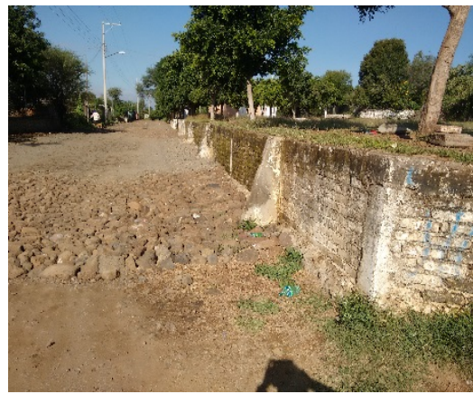
Imagen 10. Calle Lázaro Cárdenas empedrado. Fuente: Propia (2018).
