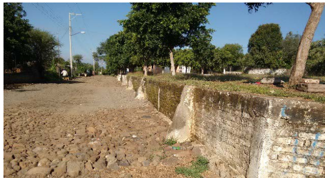
Imagen 8. Servicio de energía eléctrica y alumbrado en la calle Lázaro Cárdenas. Fuente: Propia (2018).
