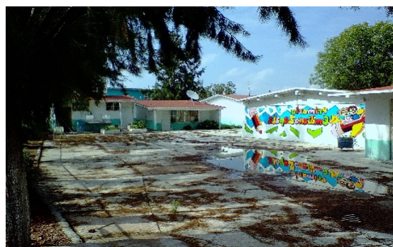
Imagen 7. Escuela primaria Emiliano Zapata. Fuente: Propia (2018).
