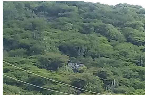
Imagen 2. Tanque superficial de la localidad, ubicado en el cerro El Venado.
