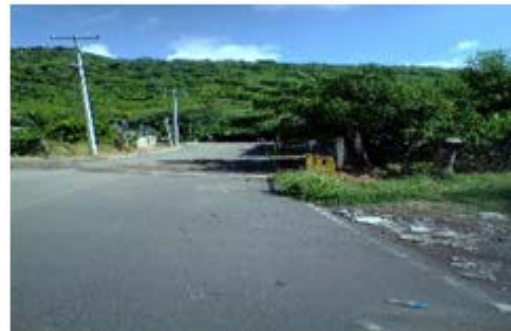
Imagen 6. Carretera hacia San Miguel del Brete, pavimento asfáltico. Fuente: Propia (2018).
