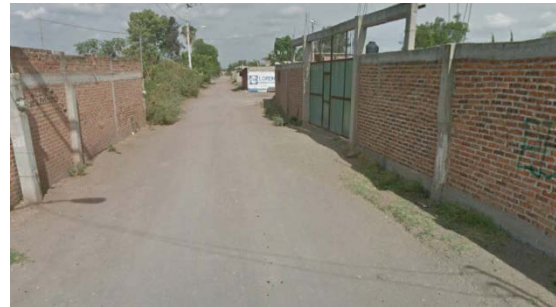
Imagen 4. Energía eléctrica y alumbrado público de alógeno en calle Reforma. Fuente: Propia (2018).
