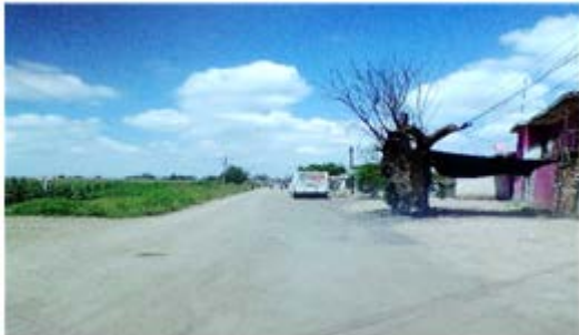
Imagen 6.- Energía eléctrica por CFE en calle Pípila. Fuente propia 2018.
