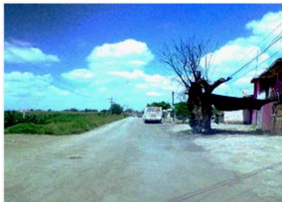
Imagen 8.- Calle Pípila pavimento asfáltico. Fuente: Propia (2018).
