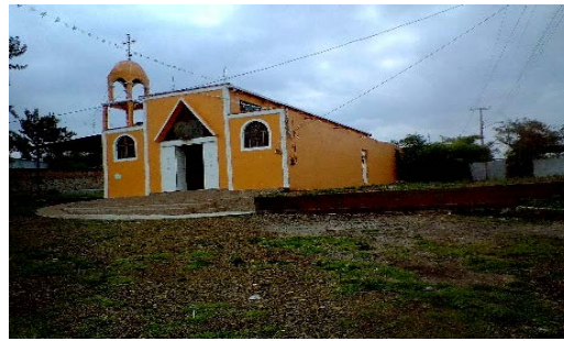
Imagen 10. Iglesia de la comunidad. Fuente: Propia (2018).
