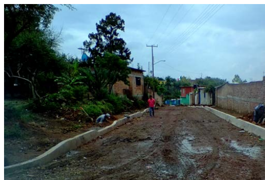
Imagen 3. Poste y cables del servicio de energía eléctrica calle Del Sol de la localidad. Fuente: Propia (2018).
