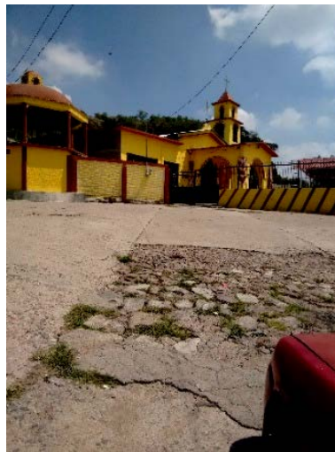
Imagen 12. Iglesia de la localidad, ubicado en la calle Ópalo. Fuente: Propia (2018).
