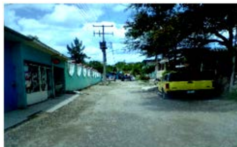
Imagen 4. Servicio de energía eléctrica en la localidad. Fuente: Propia (2018).
