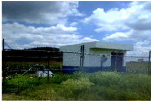
Imagen 1. Pozo de agua que proporciona servicio a la localidad. Fuente: Propia (2018).
