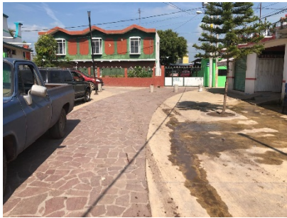
Imagen 1. Esguimiento de aguas residuales sobre plaza pública. Fuente: Propia (2018).
