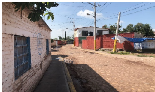
Imagen 4. Se observa red de energía eléctrica y alumbrado con que cuenta la localidad. Fuente: Propia (2018).
