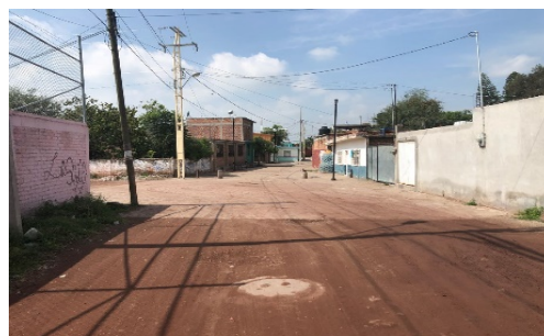
Imagen 5. Se observa red telefónica con que cuenta la localidad. Fuente: Propia (2018).
