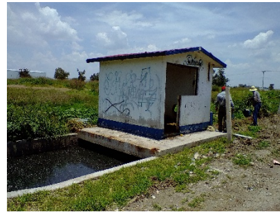
Imagen 2. Cárcamo sin equipo de la localidad. Fuente: Propia (2018).
