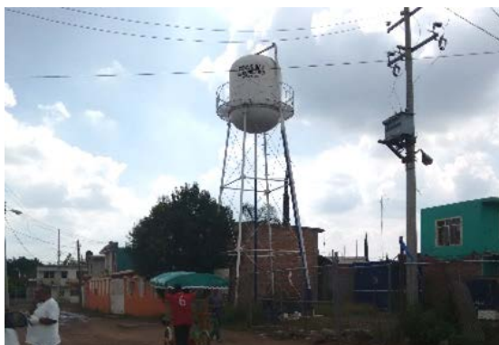
Imagen 1. Pozo y tanque elevado de la localidad. Fuente: Propia (2018).
