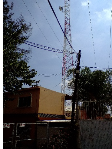
Imagen 7. Antena telefónica de la localidad. Fuente: Propia (2018).
