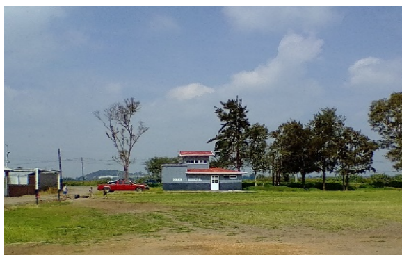
Imagen 12. Caseta de vigilancia fuera de operación. Fuente: Propia (2018).
