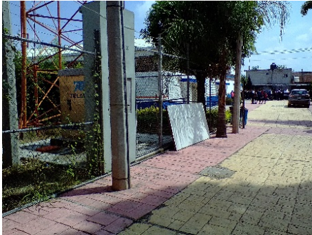
Imagen 6. Instalación de TELMEX de la localidad. Fuente: Propia (2018).
