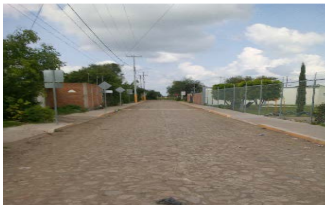
Imagen 6. Banquetas y guarniciones de la localidad. Fuente: Propia (2018).
