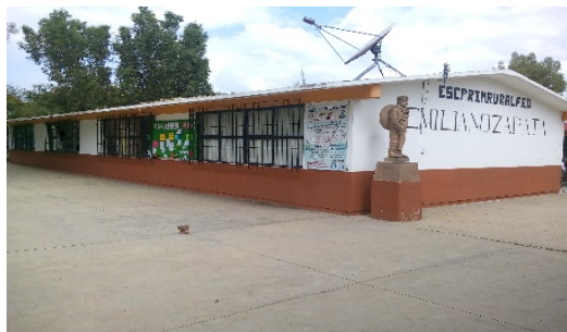
Imagen 8. Escuela primaria Emiliano Zapata. Fuente: Propia (2018).
