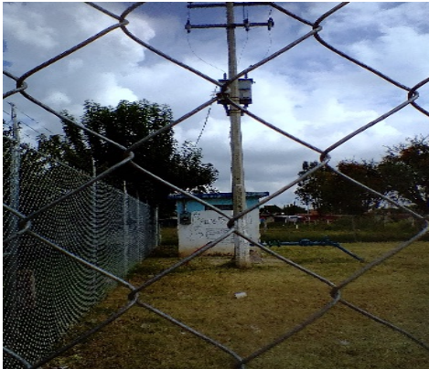
Imagen 1. Pozo de agua potable. Fuente: Propia (2018).
