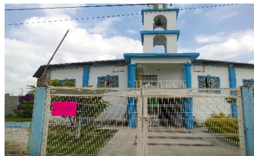
Imagen 10. Iglesia de la localidad. Fuente: Propia (2018).
