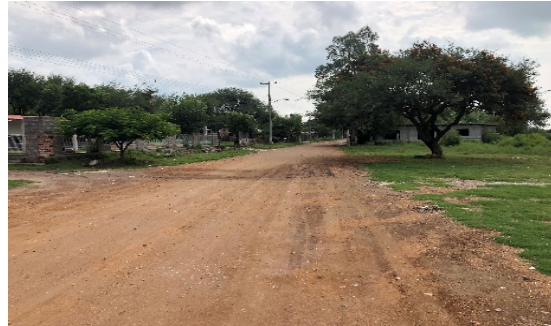
Imagen 5. Calle Principal de terracería de la localidad. Fuente: Propia (2018).
