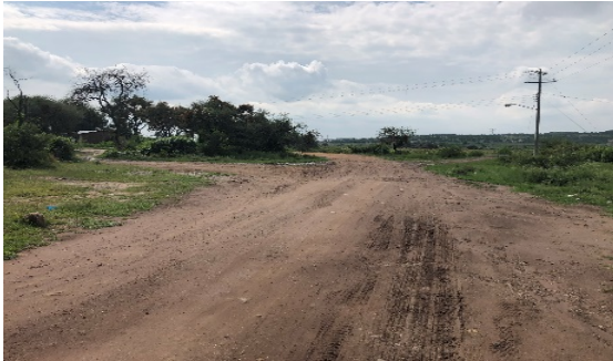
Imagen 4. Calle Principal de terracería de la localidad. Fuente: Propia (2018).
