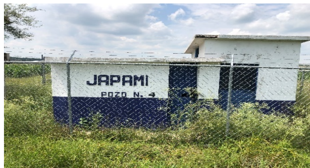
Imagen 1. Pozo de abastecimiento de agua de la localidad. Fuente: Propia (2018).
