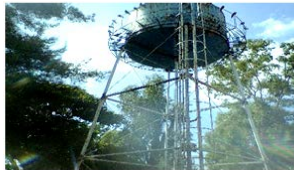
Imagen 3. Tanque elevado ubicado en calle Emiliano Zapata. Fuente: Propia (2018).
