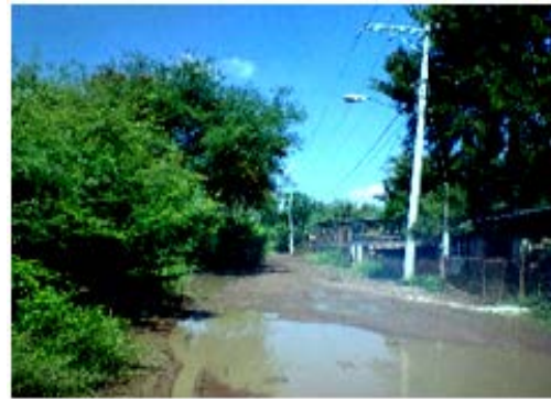
Imagen 5. Calle Fresno de la localidad sin servicio de drenaje. Fuente: Propia (2018).
