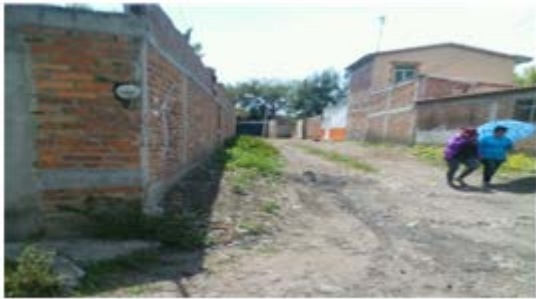
Imagen 5.- Aguas residuales escurriendo por la calle en la localidad de Rivera de Guadalupe. Fuente: Propia (2018).
