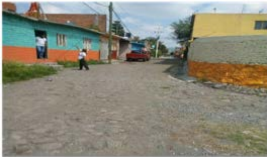
Imagen 7.- Red de energía eléctrica y red telefónica en la localidad. Fuente: Propia (2018).
