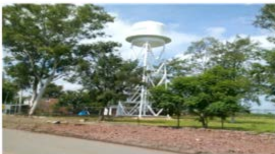
Imagen 1.- Tanque elevado nuevo de la localidad Rivera de Guadalupe. Fuente: Propia (2018).
