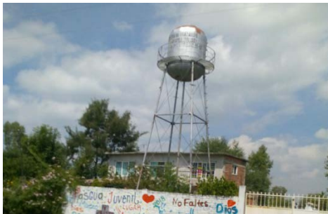
Imagen 3.- Tanque elevado fuera de operación. Fuente: Propia (2018).
