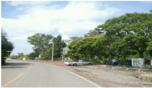
Imagen 9.- Tramo de la calle Independencia con pavimento de asfalto. Fuente: Propia (2018).
