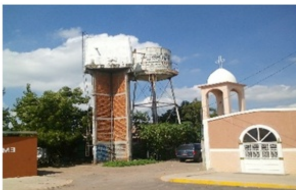
Imagen 1. Tanques elevados de la localidad. Fuente: Propia (2018).
