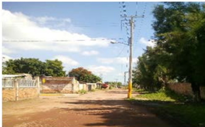
Imagen 4. Alumbrado público de la localidad. Fuente: Propia (2018).
