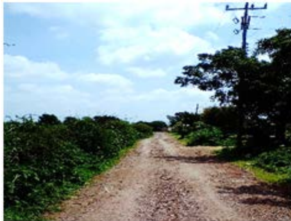
Imagen 3. Red de energía eléctrica sobre calle Camino Real. Fuente:
