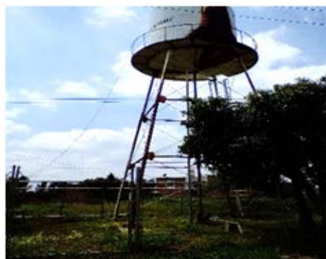
Imagen 2. Tanque elevado de la localidad. Fuente: Propia (2018).
