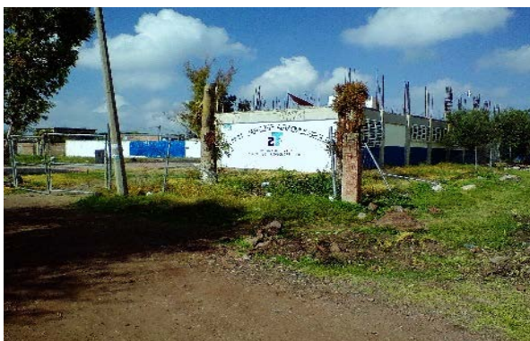
Imagen 9. Escuela telesecundaria NÚM. 9. Fuente: Propia (2018).
