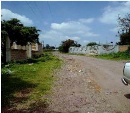
Imagen 5. Calle Central de terracería. Fuente: Propia (2018).
