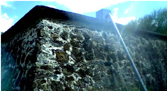
Imagen 1.- Tanque superficial de mampostería. Fuente: Propia (2018).
