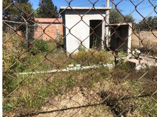
Imagen 2. Pozo de agua. Fuente: Propia (2018).
