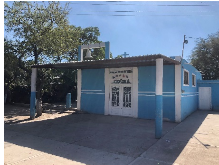
Imagen 9. Iglesia católica de la localidad. Fuente: Propia (2018).
