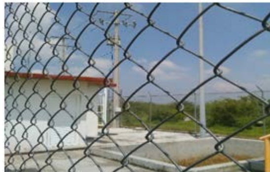
Imagen 4. Oficina de la planta sin uso. Fuente: Propia (2018).
