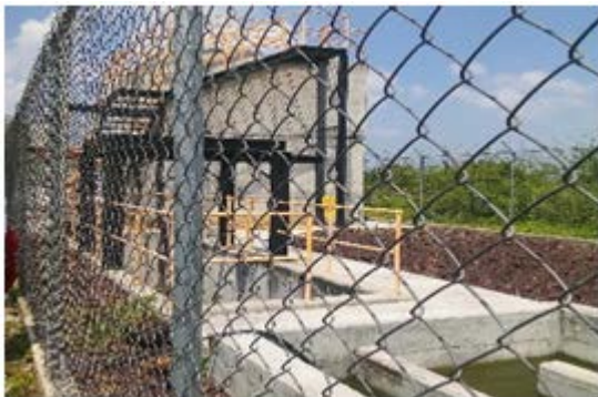
Imagen 3. PTAR sin uso. Fuente: Propia (2018).
