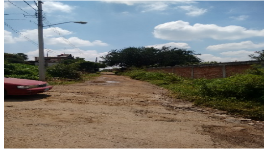
Imagen 6.- Energía eléctrica y alumbrado público en la calle Privada 1. Fuente: Propia (2018).
