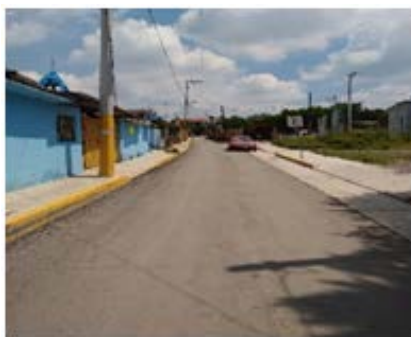
Imagen 8.- Tramo de la calle Emiliano Zapata con pavimento de concreto asfáltico y banquetas de concreto en buen estado. Fuente: propia (2018).
