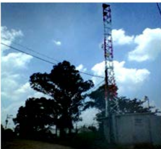
Imagen 7.- Antena de telecomunicaciones sobre calle Las Rosas. Fuente: Propia (2018).
