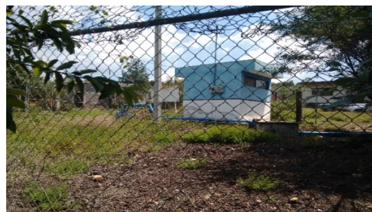
Imagen 3.- Pozo para suministro de agua a la localidad. Fuente: Propia (2018).
