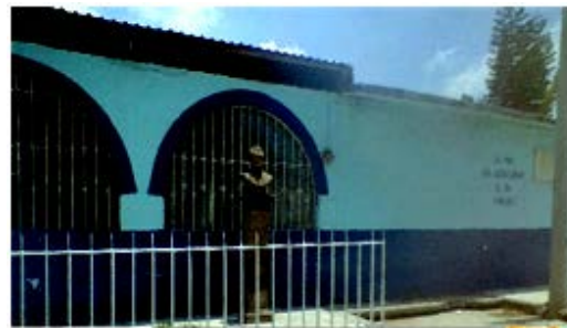
Imagen 11. Escuela Primaria Benito Juárez, acceso, Fuente: Propia (2018).
