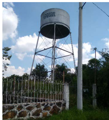
Imagen 2.- Tanque Elevado que suministra el agua a la red de la localidad. Fuente: Propia (2018).
