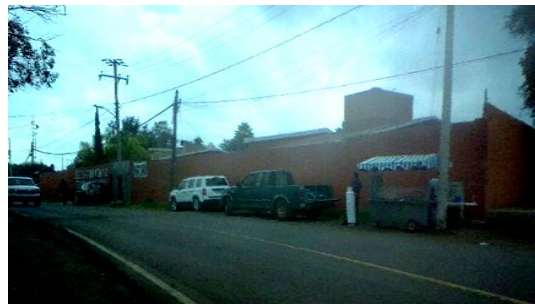
Imagen 6.- Energía eléctrica por calle Independencia. Fuente: Propia (2018).
