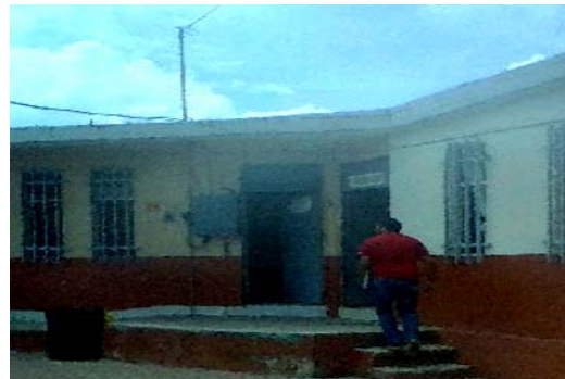
Imagen 13. Tele bachillerato. Fuente: Propia (2018).
