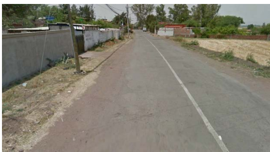
Imagen 8.- Tramo de la calle Independencia pavimento de asfalto. Fuente: Propia (2018).
