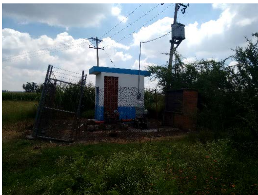
Imagen 1.- Pozo de agua potable. Fuente: Propia (2018).
