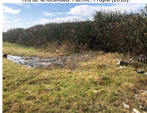
Imagen 4.- Zona contaminada por fuga de drenaje sanitario en malas condiciones. Fuente: Propia (2018).
