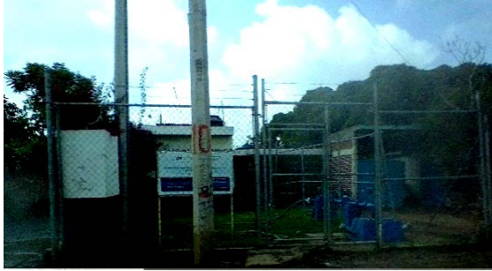
Imagen 1. Pozo profundo de la localidad, ubicado en la Calle Pípila. Fuente: Propia (2018).
