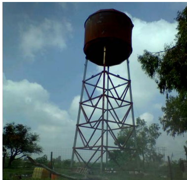
Imagen 3. Tanque elevado metálico en proceso de construcción, ubicado en la calle Hidalgo de la localidad El Carmen. Fuente: Propia (2018).
