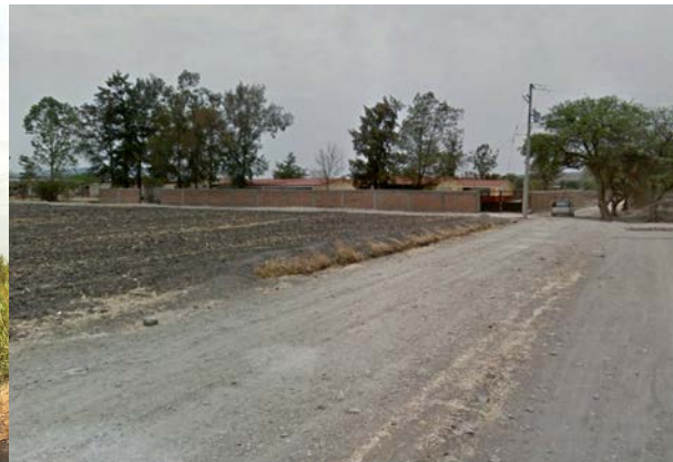
Imagen 5. Calle de acceso a la escuela primaria de Venado de San Lorenzo, sin pavimento en la localidad. Fuente: Propia (2018).
