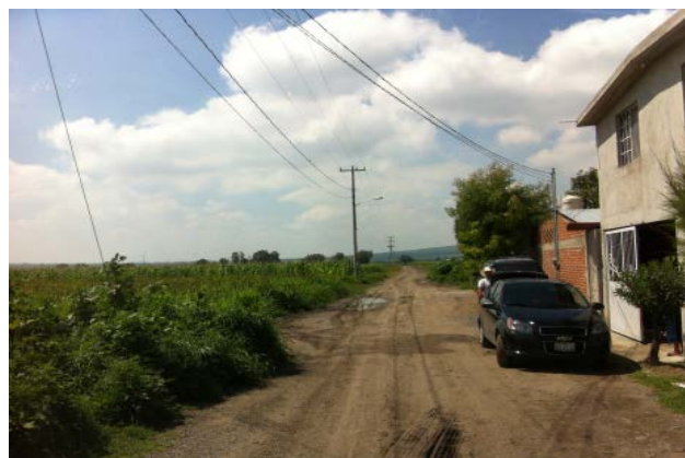
Imagen 2. Red de energía eléctrica en la localidad. Fuente: Propia (2018).
