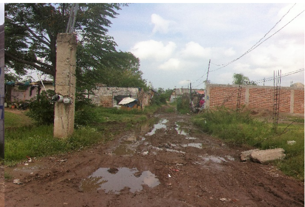
Imagen 5. Calle El Consuelo, se observa los tendidos "provisionales" para el servicio de energía eléctrica. Fuente: Propia (2018).
