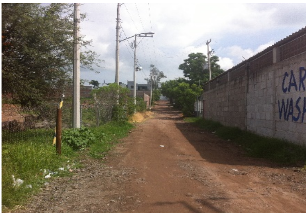
Imagen 4. Calle la Paz, se observa servicio de energía eléctrica y alumbrado público con que cuenta la localidad. Fuente: Propia (2018).
