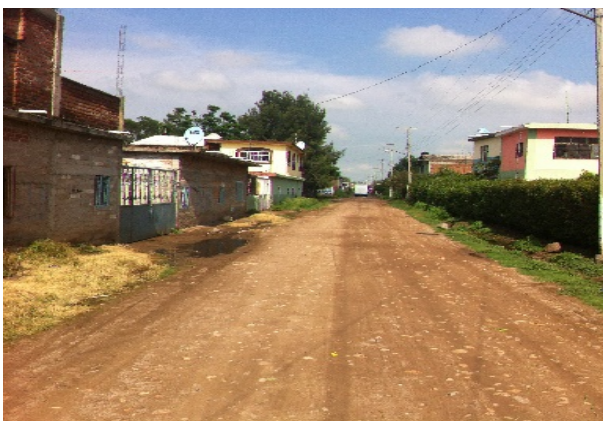
Imagen 7. Calle Emiliano Zapata sin pavimento. Fuente: Propia (2018).
