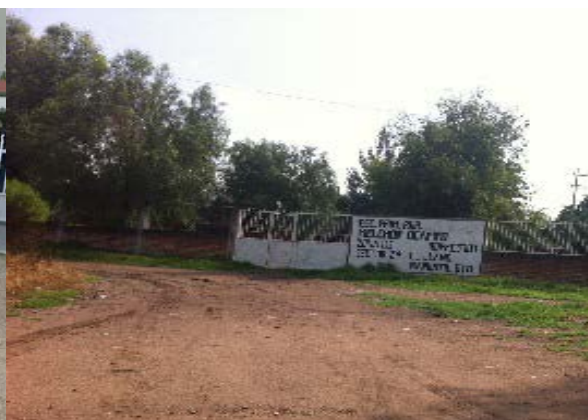
Imagen 10. Escuela primaria Melchor Ocampo. Fuente: Propia (2018).
