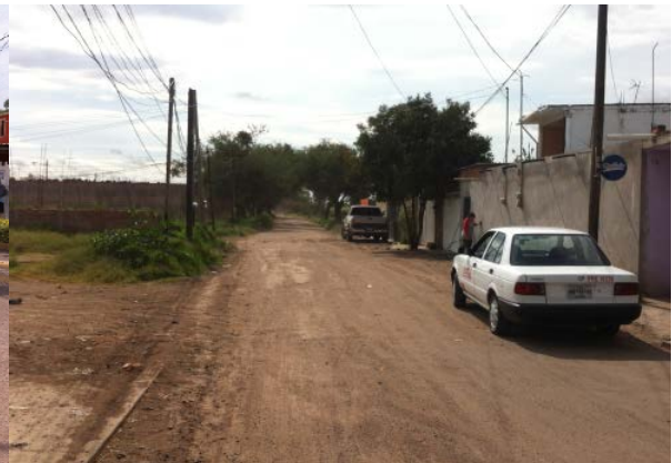
Imagen 8. Calle Juan de Zumárraga sin pavimento, vialidad que comunica con la colonia 8 de Junio. Fuente: Propia (2018).
