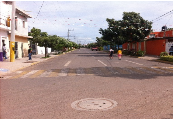
Imagen 7. Calle San Francisco cuenta con pavimento de concreto asfáltico. Fuente: Propia (2018).
