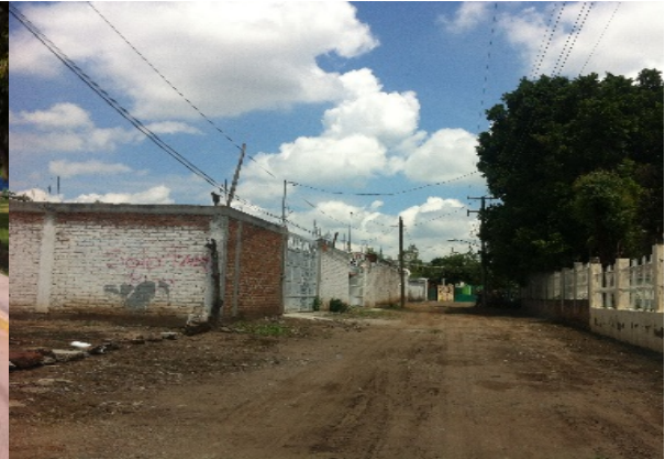
Imagen 6 Calle San Luis sin pavimento. Fuente: Propia (2018).
