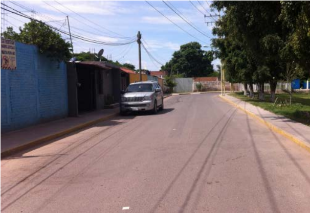
Imagen 5. Calle Berriozábal de concreto asfáltico. Fuente: Propia (2018).
