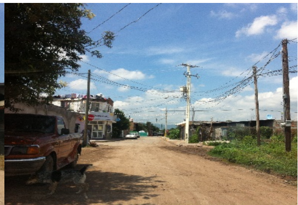
Imagen 4. Servicio de energía eléctrica, alumbrado público y líneas telefónicas en la calle Juan de Zumárraga. Fuente: Propia (2018).
