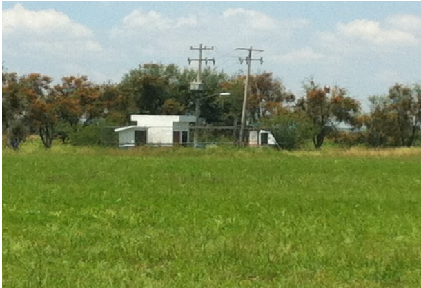
Imagen 3. Pozo que proporciona servicio a la localidad, ubicado al oriente de la localidad. Fuente: Propia (2018).
