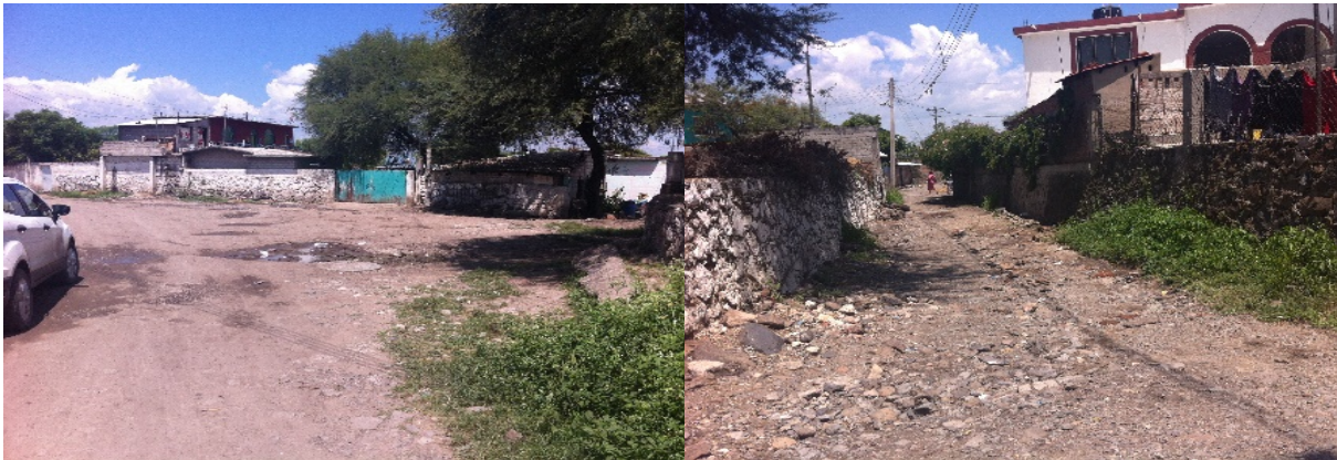
Imagen 8. Calle Vicente Guerrero sin pavimentar. Fuente: Propia (2018).
