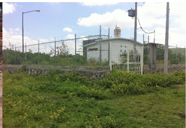
Imagen 5. Planta de tratamiento de la localidad, actualmente sin operación, sobre calle Benito Juárez. Fuente: Propia (2018).
