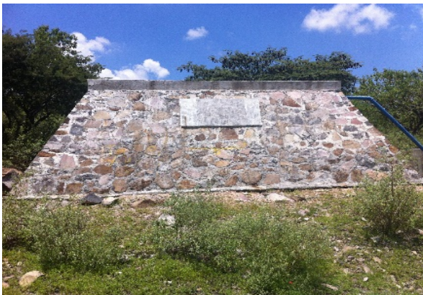
Imagen 1. Tanque superficial de mampostería, sobre la calle Francisco I. Madero. Fuente: Propia (2018).
