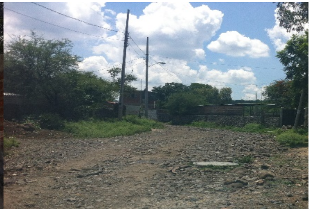
Imagen 7. Servicio de energía eléctrica y alumbrado público en la calle Benito Juárez. Fuente: Propia (2018).
