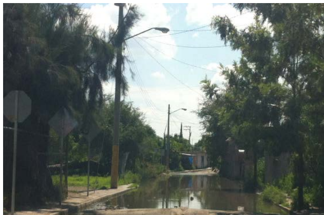
Imagen 25. Encharcamientos en la calle Casahualt, provocados por la falta de operación de los equipos de bombeo del RAFA, situación que se ve incrementada en temporada de lluvias.
