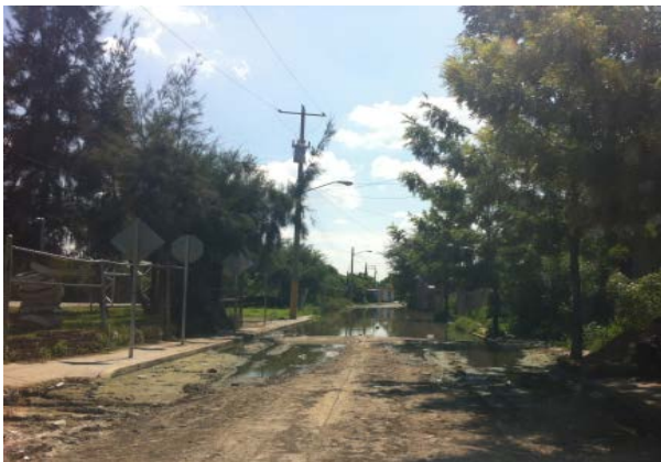
Imagen 16. Calle Casahualt, empedrada. Se observa al fondo encharcamientos. Fuente: Propia (2018).
