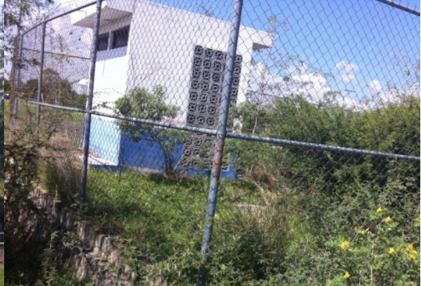
Imagen 7. Instalaciones del RAFA de la localidad. Fuente: Propia (2018).
