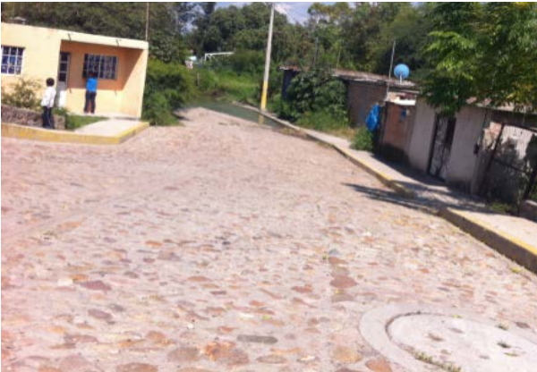
Imagen 8. Calle Casahuate de la localidad, se observa el brocal y tapa de pozo de visita de la red de drenaje. Al fondo encharcamiento de aguas. Fuente: Propia (2018).
