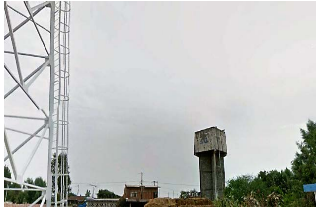
Imagen 3. Tanque elevado de concreto, fuera de operación.
