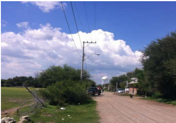
Imagen 14. Calle Mezquite no cuenta con pavimento. Fuente: Propia (2018).
