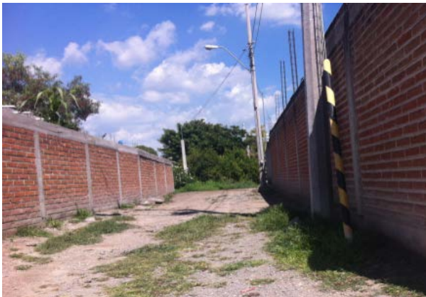
Imagen 12. Alumbrado público en la calle Pirul en la localidad. Fuente: Propia (2018).
