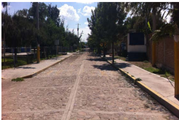
Imagen 18. Guarniciones y banquetas de concreto hidráulico en el tramo empedrado de la calle Mezquite. Fuente: Propia (2018).
