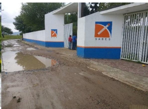
Imagen 13. telebachillerato SABES. Fuente: Propia (2018).
