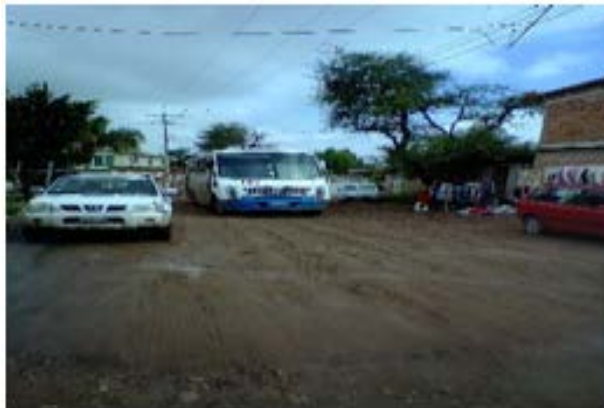
Imagen 8.- Calle Alvaro Obregón sin pavimento. Fuente: Propia (2018).
