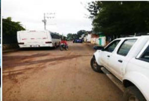
Imagen 7.- Calle 20 de noviembre con todos los servicios, pero el pavimento asfáltico en mal estado. Fuente: Propia (2018).
