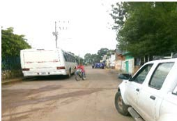
Imagen 4.- Energía eléctrica por CFE en calle con pavimento y banquetas de concreto. Fuente: Propia (2018).
