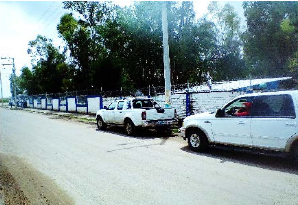
Imagen 6.- Calle Las Américas cerca de la escuela primaria con pavimento asfáltico en buen estado, banquetas y guarniciones. Fuente: Propia (2018).
