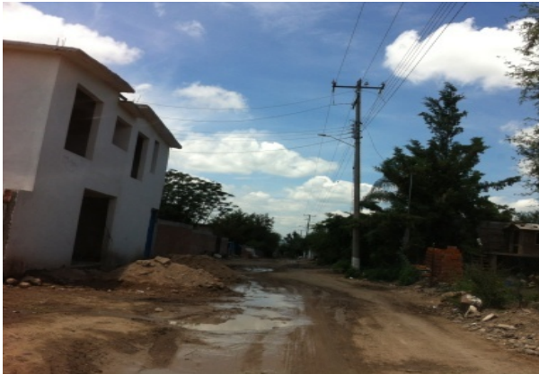
Imagen 4. Calle Vicente Guerrero, se observa red de energía eléctrica con que cuenta la localidad. Fuente: Propia (2018).
