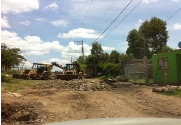
Imagen 2. Trabajos de introducción de la red de drenaje sanitario en la calle Emiliano Zapata. Fuente: Propia (2018).
