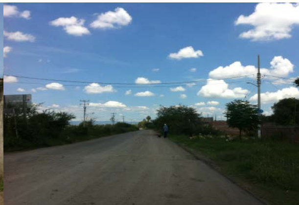
Imagen 10. Camino de acceso a la localidad, vialidad asfaltada. Fuente: Propia (2018).
