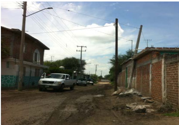
Imagen 9. Calle Emiliano Zapata, vialidad sin pavimentar. Fuente: Propia (2018).
