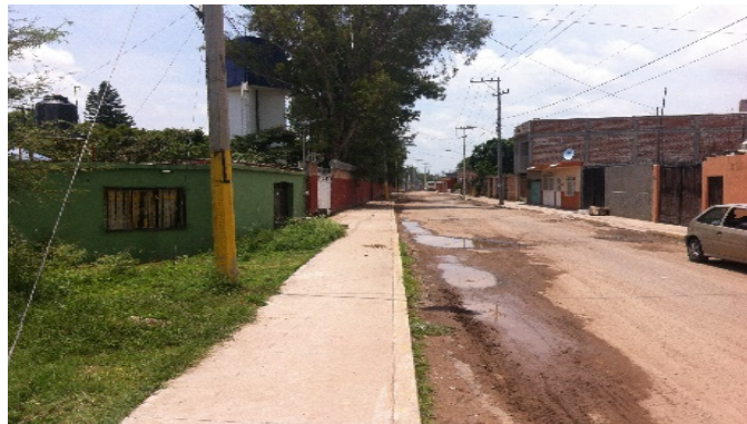
Imagen 9. Calle Pípila, se observa red de energía eléctrica con que cuenta la localidad. Fuente: Propia (2018).
