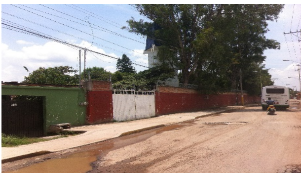
Imagen 3. Tanque elevado de la localidad. Fuente: Propia (2018).
