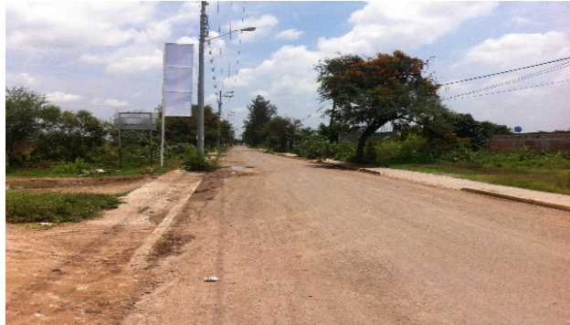
Imagen 10. Calle pípila, se observa el servicio de alumbrado público con que cuenta la localidad. Fuente: Propia (2018).
