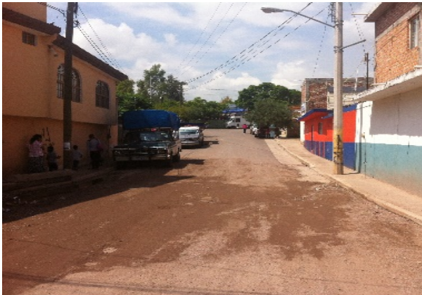
Imagen 7. Calle Fernando Dávila de concreto asfáltico, se observa en la imagen acumulación de materiales arrastrados por el agua. Fuente: Propia (2018).
