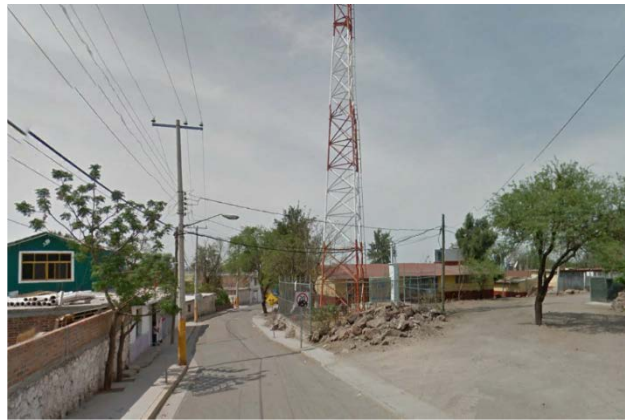
Imagen 6. Antena de telecomunicaciones ubicada en la calle Fernando Dávila de la localidad. Fuente: Propia (2018).
