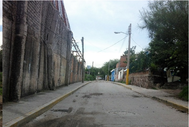
Imagen 5. Servicio de energía eléctrica, alumbrado público y líneas telefónicas en la calle Cedro. Fuente: Propia (2018).
