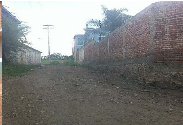
Imagen 8. Calle paseo del Bosque sin pavimentación. Fuente: Propia (2018).
