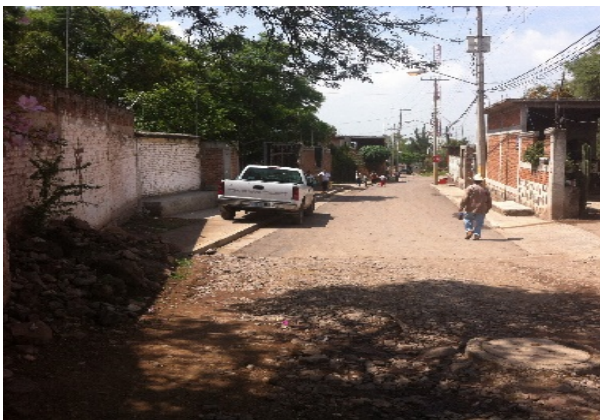
Imagen 9. Terminación de la calle Fernando Dávila en su parte de concreto asfáltico. Fuente: Propia (2018).
