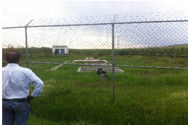
Imagen 3. PTAR de San Javier, fuera de operación. Fuente: Propia (2018).
