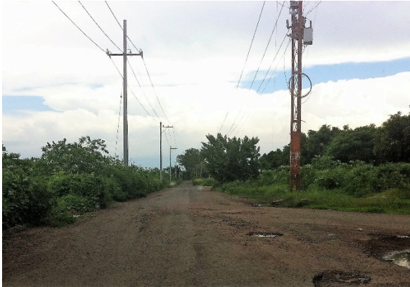
Imagen 4. Se observa servicio de energía eléctrica con que cuenta la localidad. Fuente: Propia (2018).
