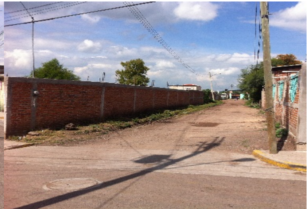
Imagen 8. Servicio de energía eléctrica, alumbrado público y líneas telefónicas en la calle Vallarta. Fuente: Propia (2018).
