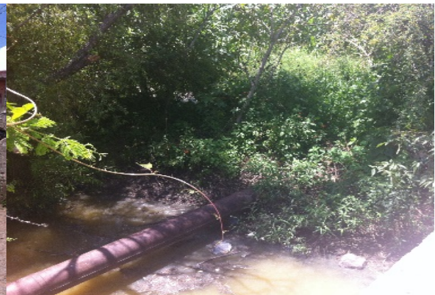
Imagen 5. Descarga de la red de drenaje. Fuente: Propia (2018).
