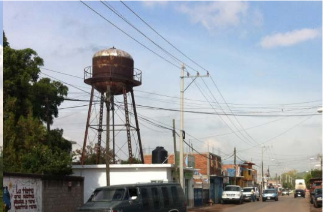
Imagen 2. Tanque elevado fuera de servicio ubicado en la calle Guerrero. Fuente: Propia (2018).
