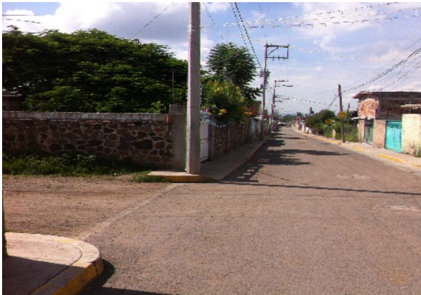
Imagen 7. Calle 6 de noviembre, se observa servicio de energía eléctrica y alumbrado público con que cuenta la localidad. Fuente: Propia (2018).
