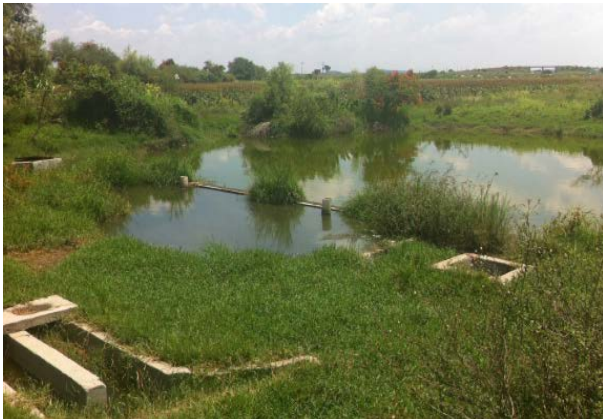
Imagen 6. Planta de tratamiento de aguas residuales sin operar. Fuente: Propia (2018).
