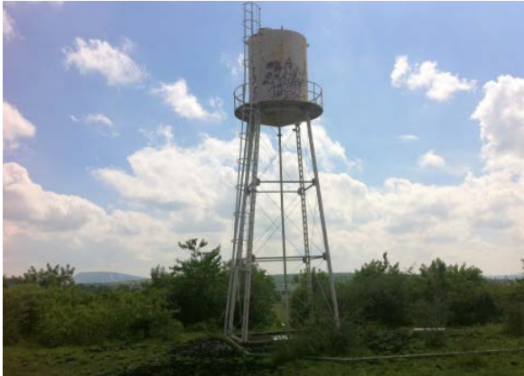
Imagen 1. Tanque elevado ubicado en la calle Pípila, que proporciona servicio a la localidad. Fuente: Propia (2018).
