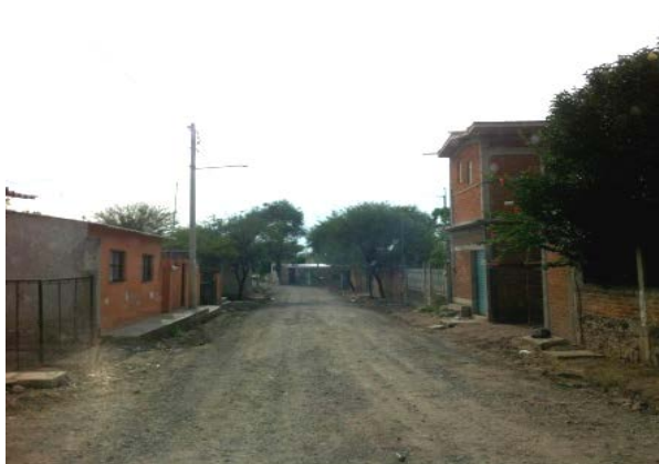
Imagen 11. Calle Chamizal, no cuenta con pavimento. Fuente: Propia (2018).
