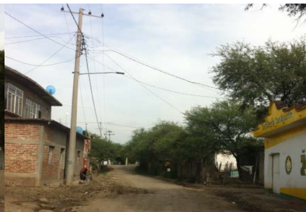
Imagen 10. Alumbrado público en la calle Morelos. Fuente: Propia (2018).
