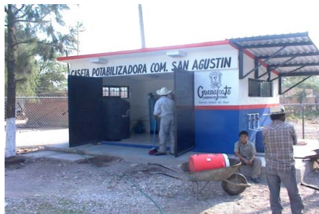
Imagen 4. Caseta potabilizadora en la localidad. Fuente: Propia (2018).
