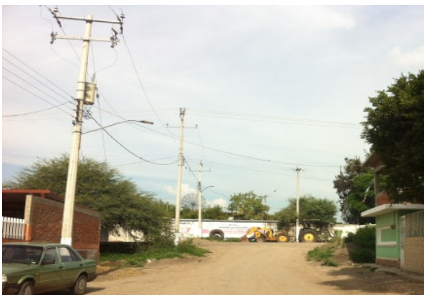
Imagen 9. Alumbrado público en la calle Calzada de los Rincones. Fuente: Propia (2018).
