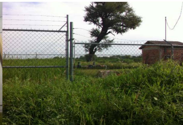
Imagen 2. Pozo profundo que abastece a la localidad de San Agustín de los Tordos. Fuente: Propia (2018).
