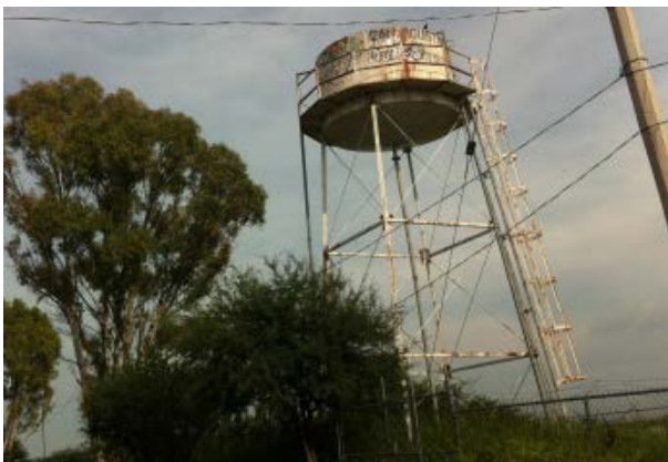
Imagen 1. Tanque elevado ubicado en el camino a Santa Bárbara. Fuente: Propia (2018).
