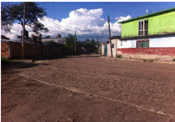
Imagen 5. Red de energía eléctrica, en la calle las Rosas. Fuente: Propia (2018).
