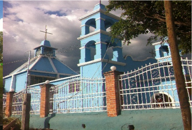
Imagen 10. Iglesia de la localidad. Fuente: Propia (2018).
