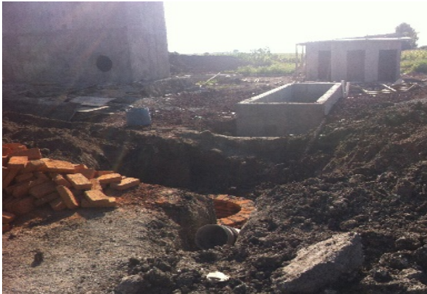
Imagen 3. Planta de tratamiento en proceso de construcción. Fuente: Propia (2018).
