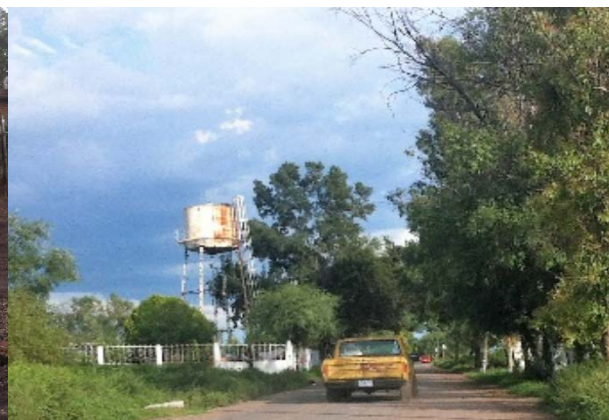
Imagen 2. Tanque elevado de la localidad, ubicado en el camino de acceso a Purísima de Covarrubias. Fuente: Propia (2018).
