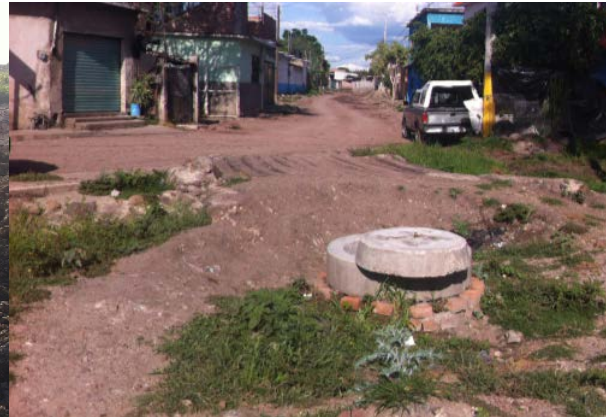
Imagen 4. Red de drenaje sanitario, en proceso de construcción. Fuente: Propia (2018).
