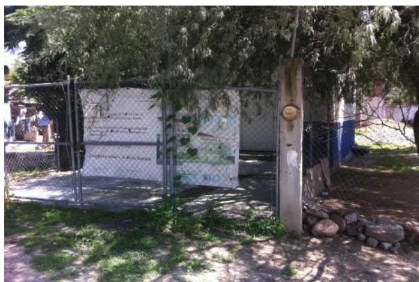
Imagen 3. Planta potabilizadora en la localidad. Fuente: Propia (2018).
