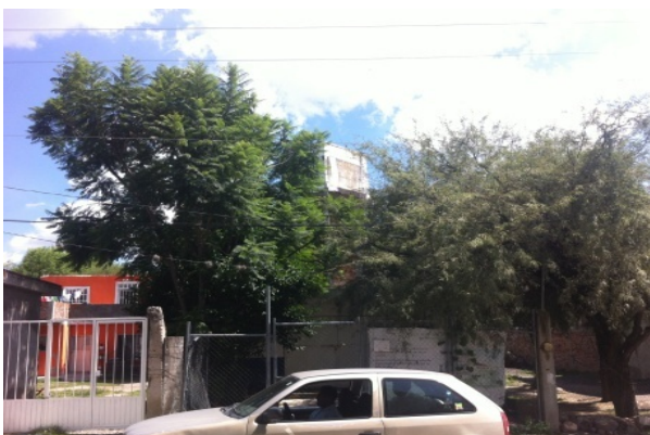
Imagen 1. Tanque elevado y planta purificadora, ubicados en la calle Miguel Hidalgo. Fuente: Propia (2018).
