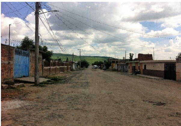
Imagen 6. Calle Francisco I. Madero, se observa red de energía eléctrica y alumbrado público con que cuenta la localidad. Fuente: Propia (2018).
