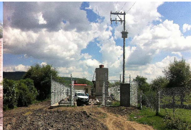
Imagen 5. Planta de tratamiento de la localidad, en proceso de construcción. Fuente: Propia (2018).
