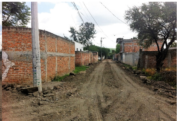
Imagen 7. Calle Vicente Guerrero, red de energía eléctrica. Fuente: Propia (2018).
