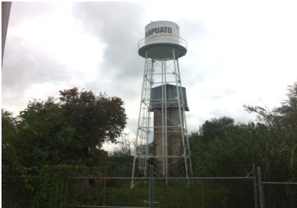
Imagen 1. Tanque metálico elevado al frente y al fondo tanque de concreto fuera de servicio, ubicados en la Avenida del Trabajo. Fuente: Propia (2018).
