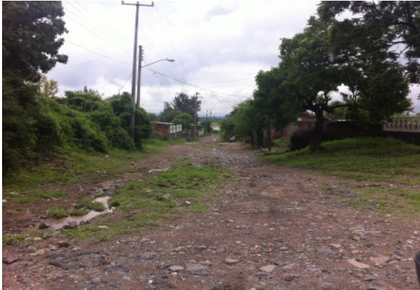
Imagen 3. Calle Navidad, se observa red de energía eléctrica y alumbrado con que cuenta la localidad. Fuente: Propia (2018).
