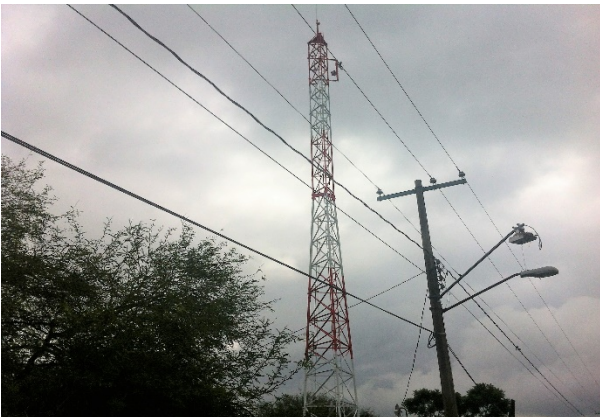
Imagen 7. Antena de telecomunicaciones ubicada en la Avenida del Trabajo de la localidad. Fuente: Propia (2018).
