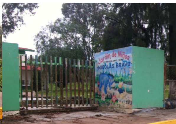
Imagen 14. Acceso a la escuela preescolar Nicolás Bravo. Fuente: Propia (2018).
