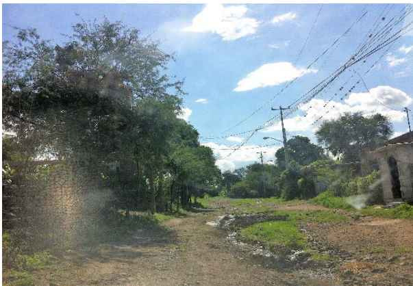
Imagen 11. Calle Navidad no cuenta con pavimento. Fuente: Propia (2018).
