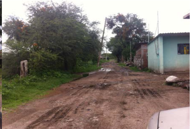
Imagen 4. Calle Cerrito, red de energía eléctrica. Fuente: Propia (2018).
