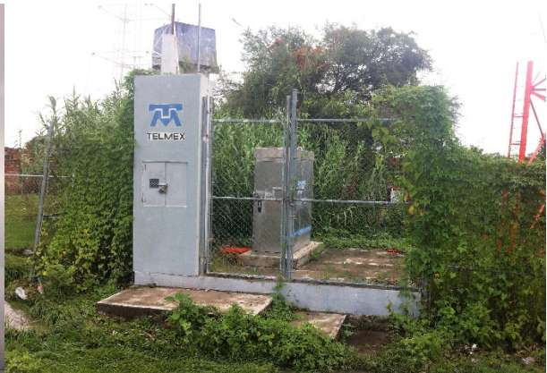
Imagen 8. Instalaciones de Telmex en la localidad y antena. Fuente: Propia (2018).
