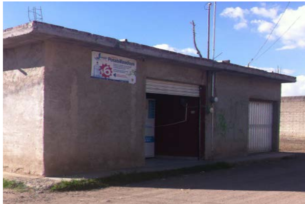
Imagen 3. Planta potabilizadora en la localidad. Fuente: Propia (2018).
