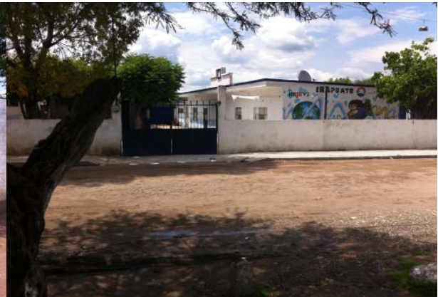
Imagen 63. Acceso escuela primaria Venustiano Carranza. Fuente: Propia (2018).
