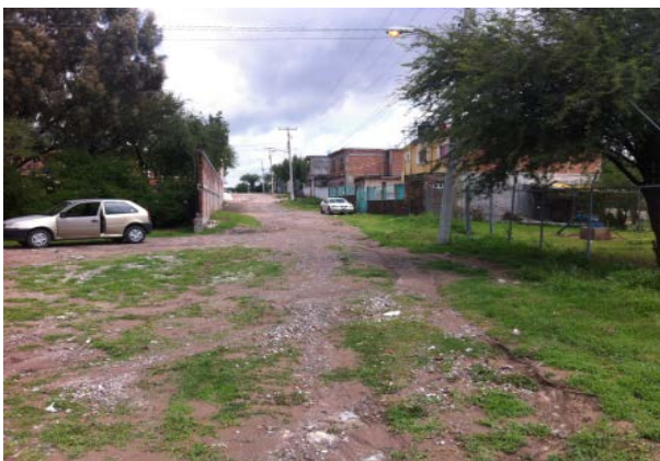
Imagen 6. Calle Venustiano Carranza, se observa red de energía eléctrica y alumbrado público con que cuenta la localidad. Fuente: Propia (2018).
