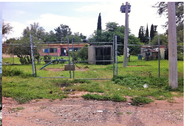
Imagen 2. Pozo profundo que abastece a la localidad de Guadalupe de Paso Blanco. Fuente: Propia (2018).
