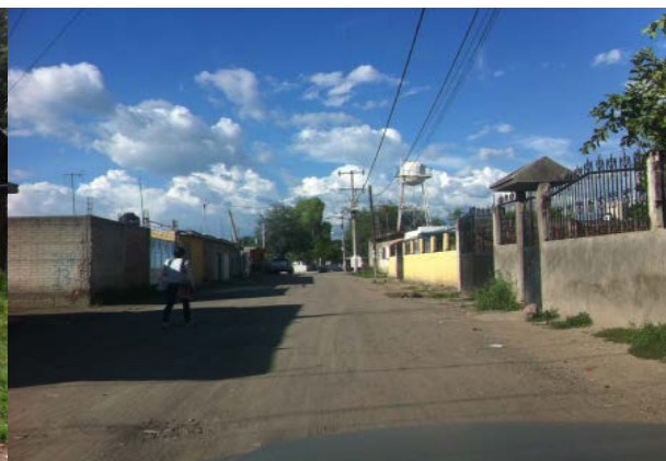
Imagen 7. Calle Guerrero, red de energía eléctrica. Fuente: Propia (2018).
