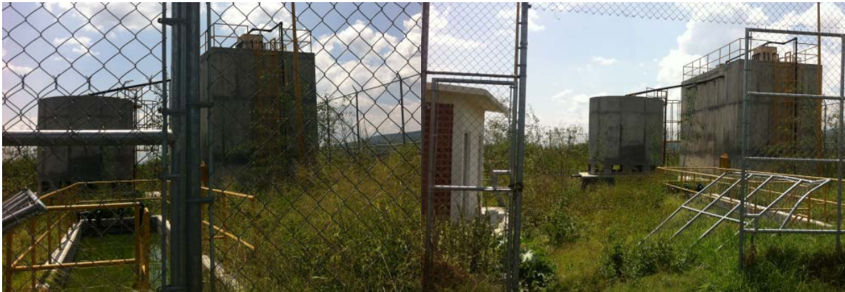
Imagen 7. Planta de tratamiento en la localidad. Fuente: Propia (2018).
