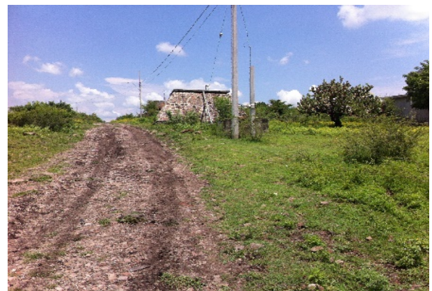
Imagen 2. Tanque superficial en la calle Independencia. Fuente: Propia (2018).
