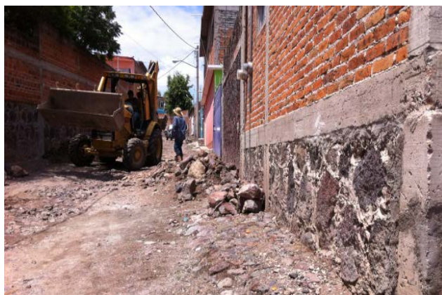
Imagen 15. Calle Libertad donde se construirán guarniciones y banquetas.
