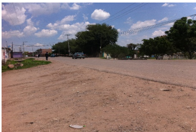
Imagen 14. Parte de la calle Emiliano Zapata sin pavimentar. Fuente: Propia (2018).
