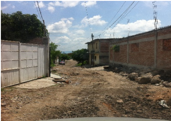
Imagen 9. Calle Libertad, se observa red de energía eléctrica y telefonía con que cuenta la localidad. Fuente: Propia (2018).
