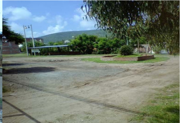
Imagen 10. Calle Vicente Suarez sin pavimento. Fuente: Propia (2018).
