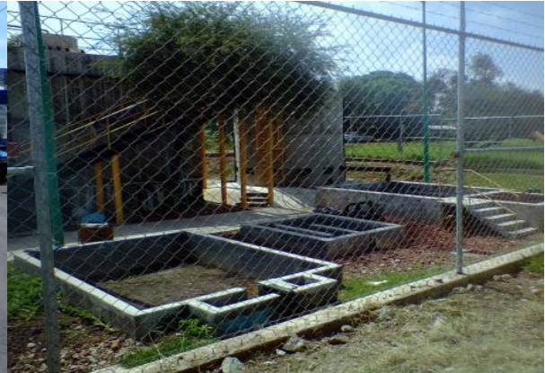
Imagen 4. Planta de tratamiento de la localidad, sin operar. Fuente: Propia (2018).
