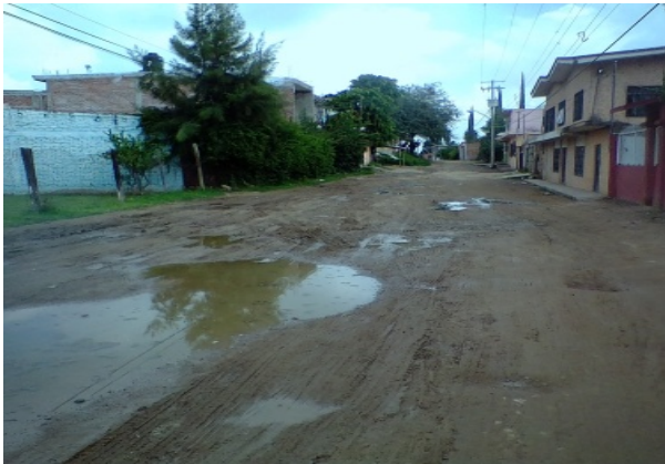
Imagen 5. Calle Juan Escutia, se observa red de energía eléctrica con que cuenta la localidad. Fuente: Propia (2018).
