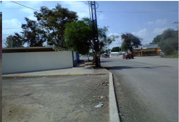
Imagen 6. Avenida Arandas, red de energía eléctrica. Fuente: Propia (2018).
