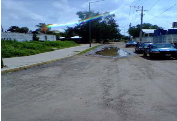
Imagen 3. Pozo de visita en la calle Sagrado Corazón de Jesús. Fuente: Propia (2018).
