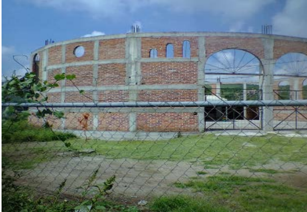
Imagen 14. Templo en la localidad, aún en proceso de construcción. Fuente: Propia (2018).
