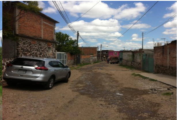
Imagen 7. Calle Hidalgo, red de energía eléctrica. Fuente: Propia (2018).
