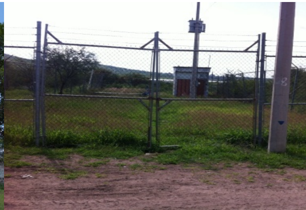
Imagen 2. Pozo profundo que abastece a la localidad de La Caja, ubicado en la calle Francisco I. Madero. Fuente: Propia (2018).
