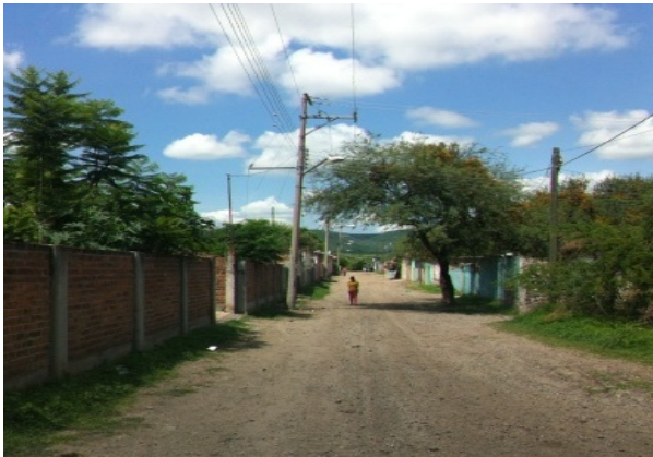
Imagen 6. Calle Las Camelina, se observa red de energía eléctrica y alumbrado público con que cuenta la localidad. Fuente: Propia (2018).
