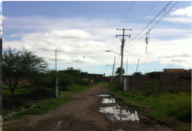
Imagen 9. Aluminado público en la calle Francisco I. Madero. Fuente: Propia (2018).
