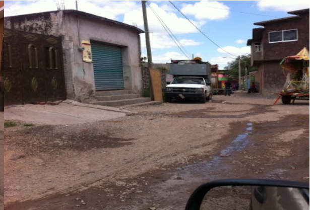
Imagen 5. Calle Hidalgo, se observan aguas residuales escurriendo por el arroyo de la calle. Fuente: Propia (2018).
