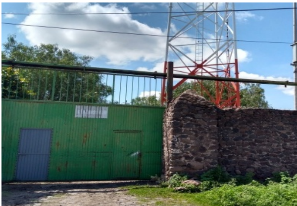
Imagen 10. Antena de telecomunicaciones ubicada en calle Los Laureles de la localidad. Fuente: Propia (2018).
