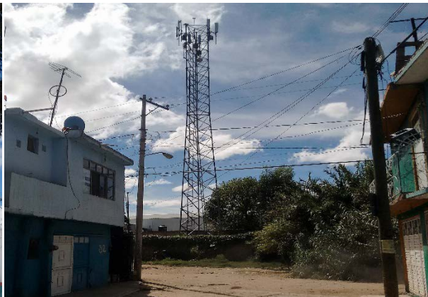
Imagen 9. Antena en calle división de Arandas. Fuente: Propia (2018).
