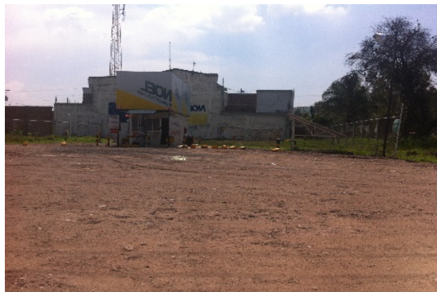
Imagen 18. Instalaciones de gasera en la localidad. Fuente: Propia (2018).
