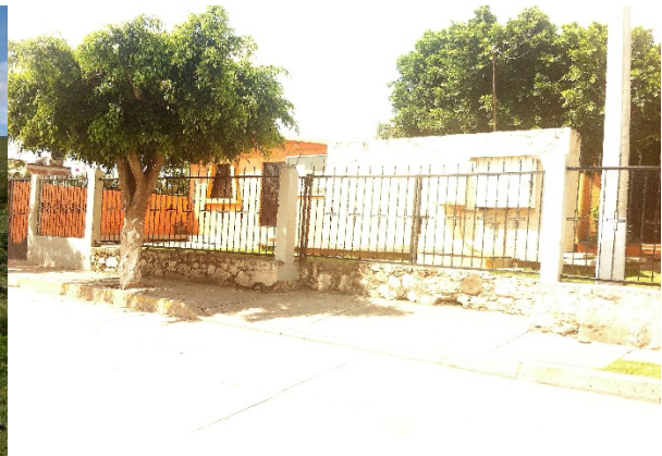
Imagen 2. Pozo profundo en la calle Morelos, ubicado en la explanada del templo. Fuente: Propia (2018).
