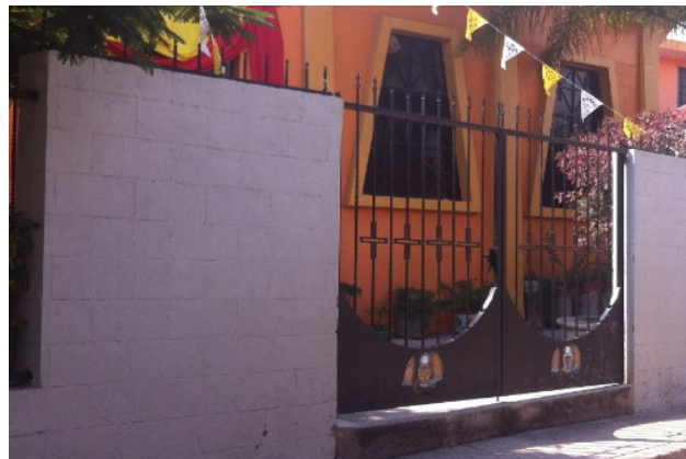
Imagen 17. Parroquia en la localidad, ubicada en la calle señor de Esquipulas. Fuente: Propia (2018).
