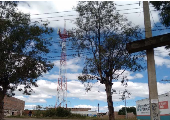
Imagen 8. Antena en calle Guanajuato. Fuente: Propia (2018).
