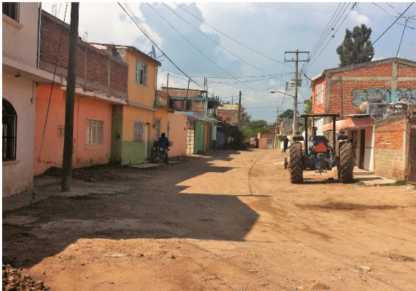
Imagen 10. Calle Díaz Ordaz, sin pavimento. Fuente: Propia (2018).
