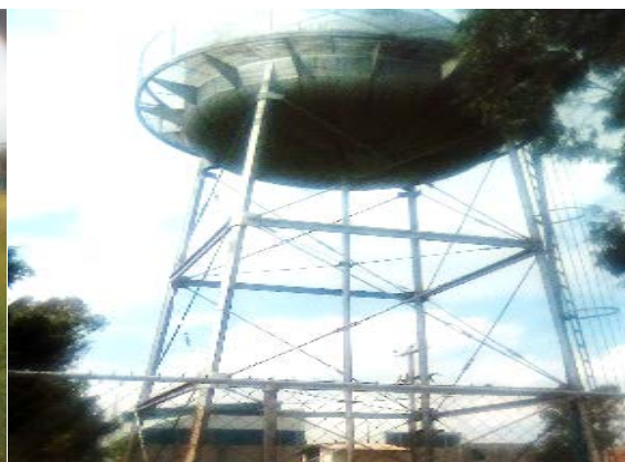
Imagen 3. Tanque metálico elevado. Fuente: Propia (2018).
