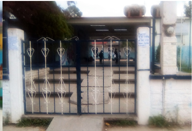
Imagen 13. Acceso a la primaria y secundaria, mismas instalaciones. Fuente: Propia (2018).
