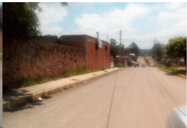
Imagen 7. Línea de energía eléctrica y telefonía sobre calle principal. Fuente: Propia (2018)
