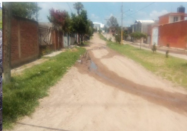
Imagen 5. Esguimiento por línea tapada en calle La Poza. Fuente: Propia (2018).
