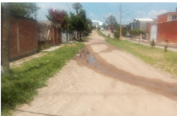
Imagen 20. Esguerrimiento de aguas residuales sobre calle La Poza. Fuente: Propia (2018)
