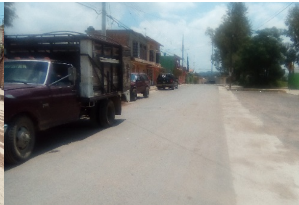
Imagen 9. Calle Trinidad pavimentada con asfalto. Fuente: Propia (2018).
