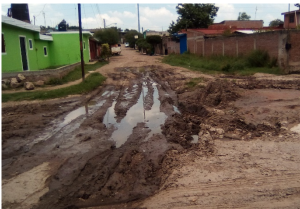
Imagen 10. Calle Guadalupe Victoria sin pavimentar. Fuente: Propia (2018).
