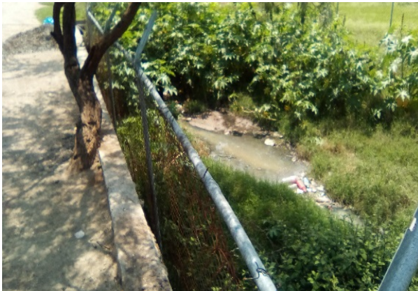
Imagen 1. Descarga de drenaje a cárcamo sin uso: Propia (2018).
