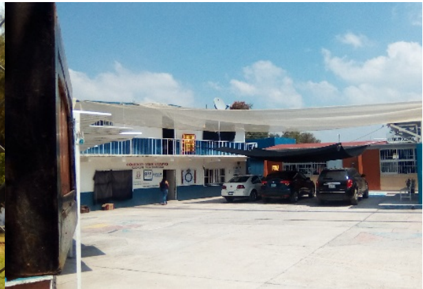
Imagen 7. Primaria Lázaro Cárdenas. Fuente: Propia (2018).
