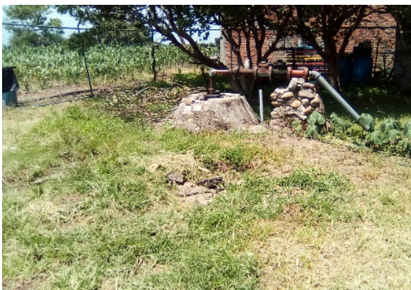
Imagen 2. Pozo de agua. Fuente: Propia (2018).
