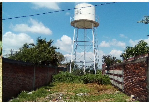
Imagen 3. Tanque metálico elevado sin uso. Fuente: Propia (2018).
