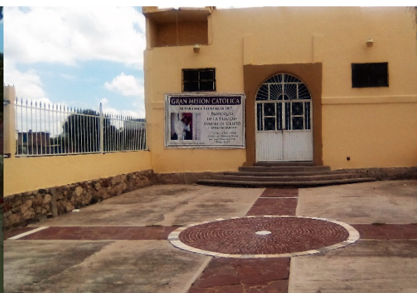
Imagen 11. Iglesia católica. Fuente: Propia (2018).
