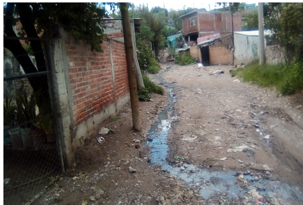
Imagen 3. Aguas jabonosas en vialidad. Fuente: Propia (2018).
