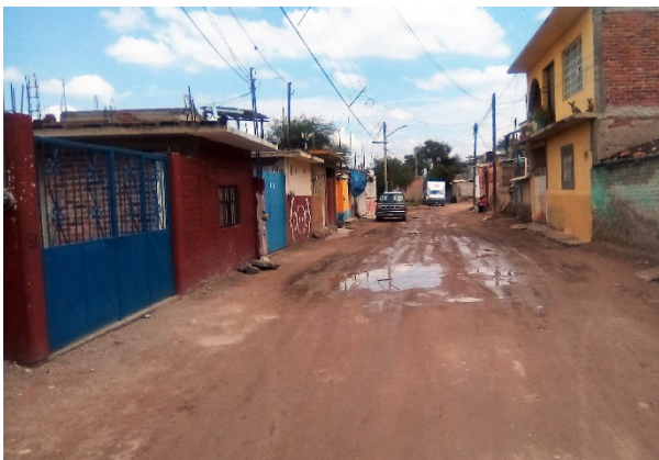
Imagen 4. Línea de Energía eléctrica en la calle Francisco I. Madero. Fuente: Propia (2018).
