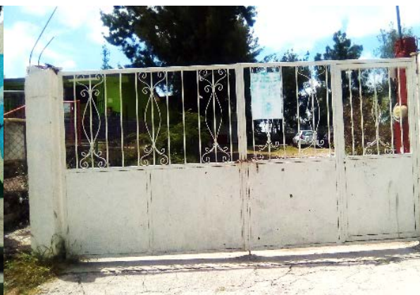
Imagen 9. Acceso a primaria. Fuente: Propia (2018).
