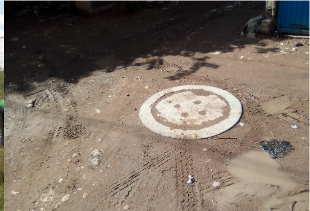
Imagen 4. Pozo de visita en calle priv. San Vicente. Fuente: Propia (2018).
