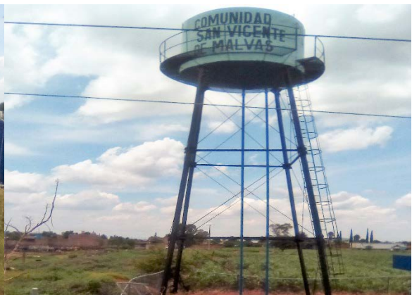
Imagen 2. Tanque metálico elevado. Fuente: Propia (2018).
