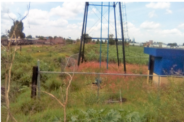
Imagen 1. Pozo de agua. Fuente: Propia (2018).
