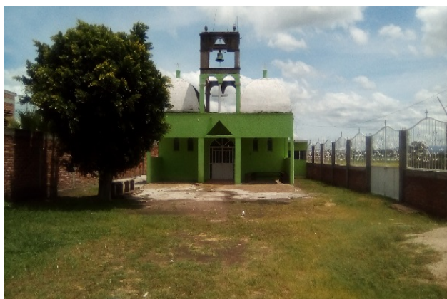
Imagen 10. Iglesia católica. Fuente: Propia (2018)
