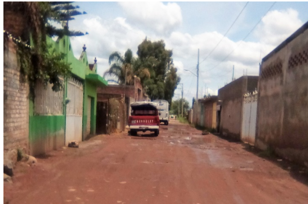
Imagen 5. Línea de energía eléctrica y telefonía en calle Lázaro Cárdenas. Fuente: Propia (2018).
