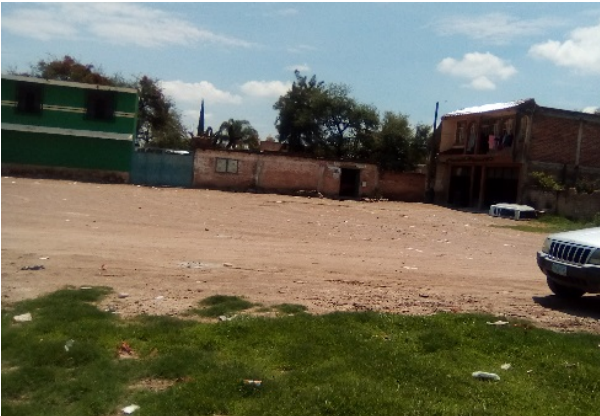
Imagen 7. Zona sin servicio de red eléctrica ni alumbrado. Fuente: Propia (2018).
