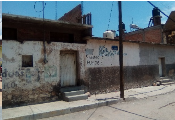
Imagen 9. Calle Nilda pavimento asfáltico. Fuente: Propia (2018).
