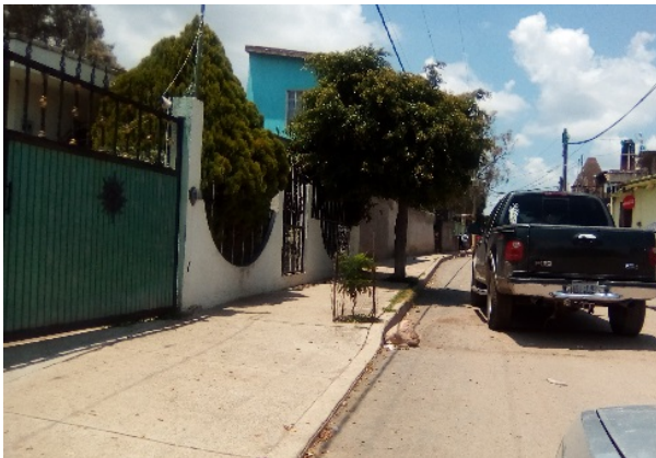
Imagen 8. Calle 5 de mayo pavimento asfáltico. Fuente: Propia (2018).
