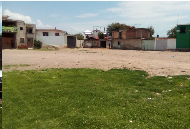
Imagen 8. Zona sin servicio de red eléctrica ni alumbrado. Fuente: Propia (2018).
