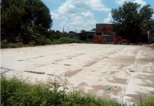
Imagen 15. Cancha de usos múltiples. Fuente: Propia (2018).
