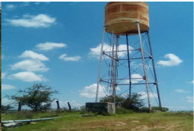
Imagen 2.- Tanque Elevado que suministra el agua a la red de la localidad. Fuente: Propia (2018).
