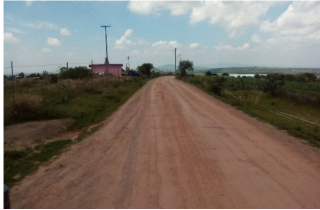
Imagen 3.- Energía eléctrica por CFE y alumbrado en calle de acceso. Fuente: Propia (2018).
