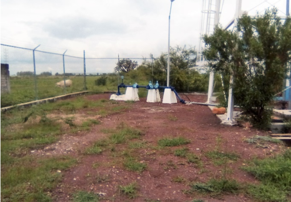
Imagen 1. Pozo de agua calle León. Fuente: Propia (2018).
