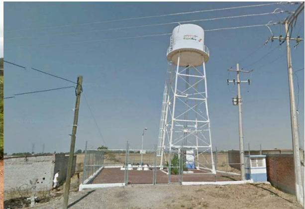
Imagen 4. Tanque elevado metálico. Fuente: Propia (2018).
