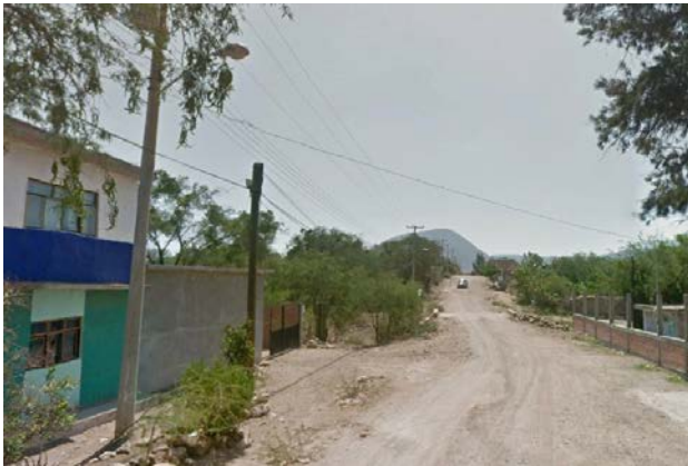
Imagen 5. Línea de energía eléctrica en calle Álvaro Obregón. Fuente: Propia (2018).
