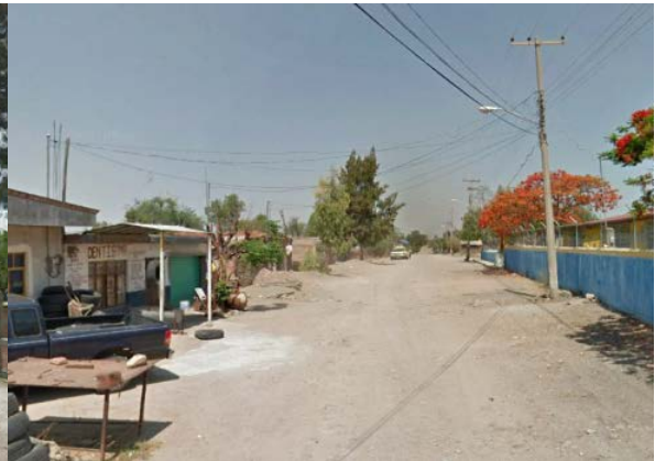
Imagen 6. Línea de energía eléctrica en Av. del Trabajo. Fuente: Propia (2018).
