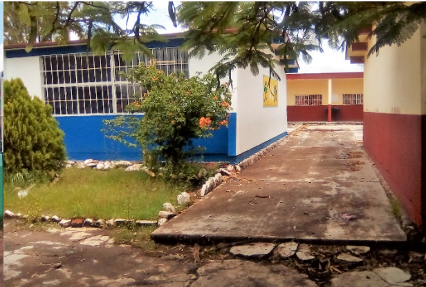
Imagen 9. Acceso a la primaria. Fuente: Propia (2018).
