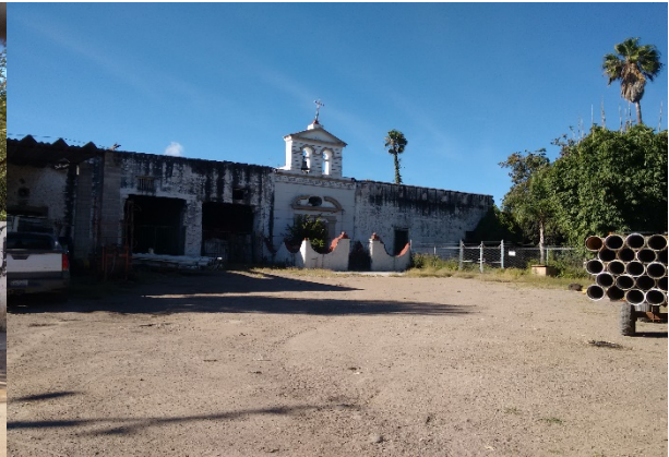
Imagen 11. Iglesia católica en casco de hacienda. Fuente: Propia (2018)
