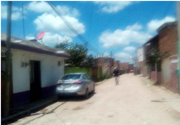
Imagen 3. Red de energía eléctrica. Fuente: Propia (2018).
