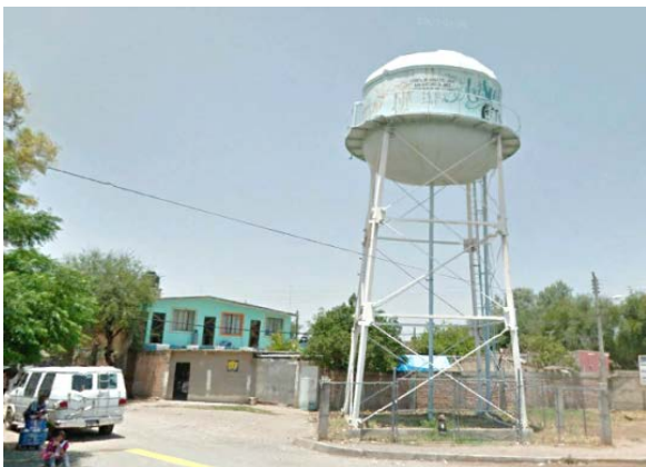
Imagen 1. Tanque elevado metálico. Fuente: Propia (2018).
