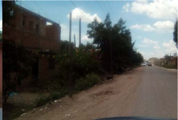
Imagen 2. Línea de energía eléctrica y telefonía sobre Av. Del Trabajo. Fuente: Propia (2018)
