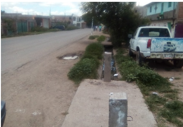
Imagen 3. Carretera asfaltada. Fuente: Propia (2018).
